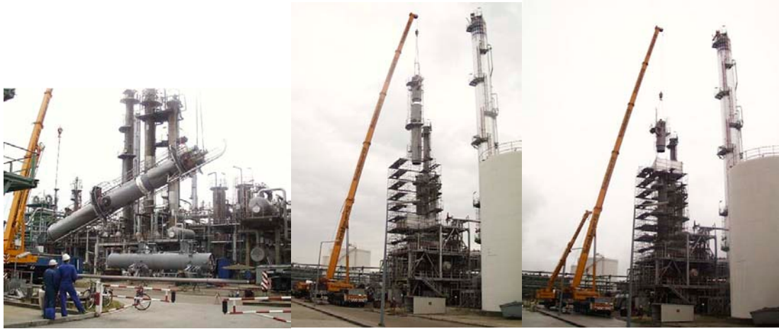
c. VEBA Ól Krupp/Uhde benzeenverwijderingskolom 160.000 ton/jaar
